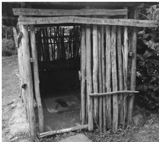
L'utilisation des latrines comme celle-ci aide à contrôler la propagation du trachome.
